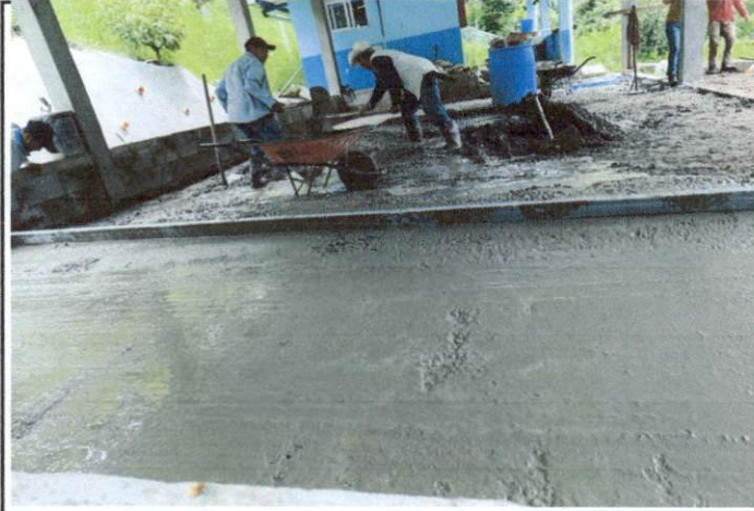
Foto 1: Mejoramiento de Loza ya existente
